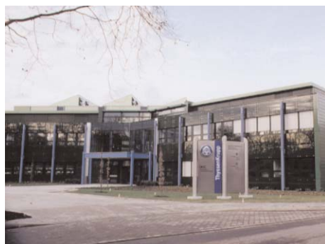
Gebäude des Dortmunder OberflächenCentrums
